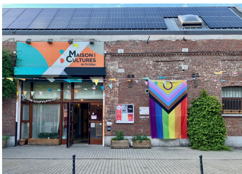
Installation photovoltaïque sur les toits de la maison des cultures à Saint-Gilles
