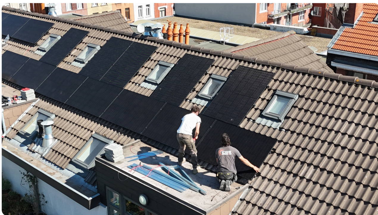
Installatie van zonnepanelen op het Vanderkindere-appartementencomplex in Molenbeek in april 2026.
